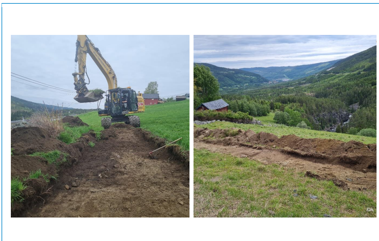
Figur 9: Sjakter ved Tufto. Sjakt på nordsiden av veien hvor jernvinneanleggene ID289658-1-2 ligger tv., sett mot SV og th. sjakt på sørsiden av veien, sett mot sør.
